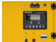
Интуитивно понятная панель управления позволяет управлять генератором, а так же отслеживать параметры двигателя.
