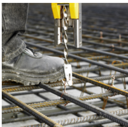
4. Потяните дальше до автоматического срабатывания механизма: Узел затягивается
